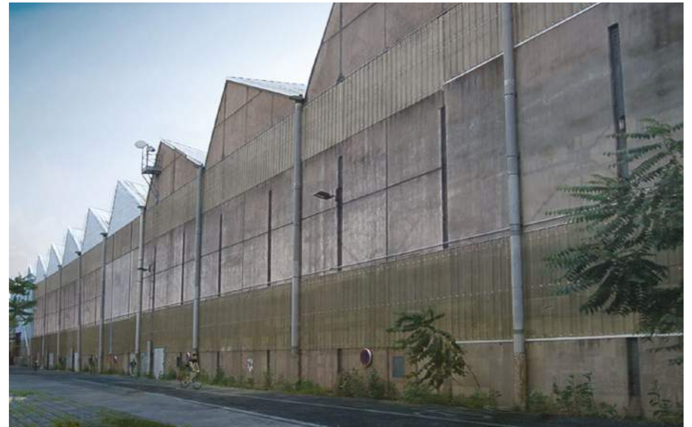
PHOTO DE LA FAÇADE EXISTANTE HALLE 4
