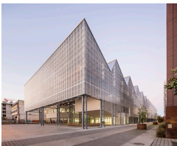
Site de Nantes. Ouvert depuis septembre 2017 Architecture Franklin Azzi, 2017. Photo Luc Boegly
