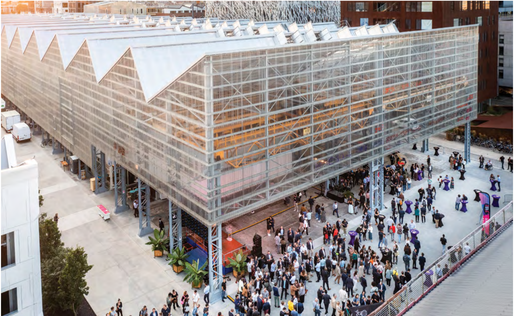
Parvis de l'École des beaux-arts Nantes Saint-Nazaire, site Nantes, 2021. Photo : Valéry Joncheray/Samoa.
