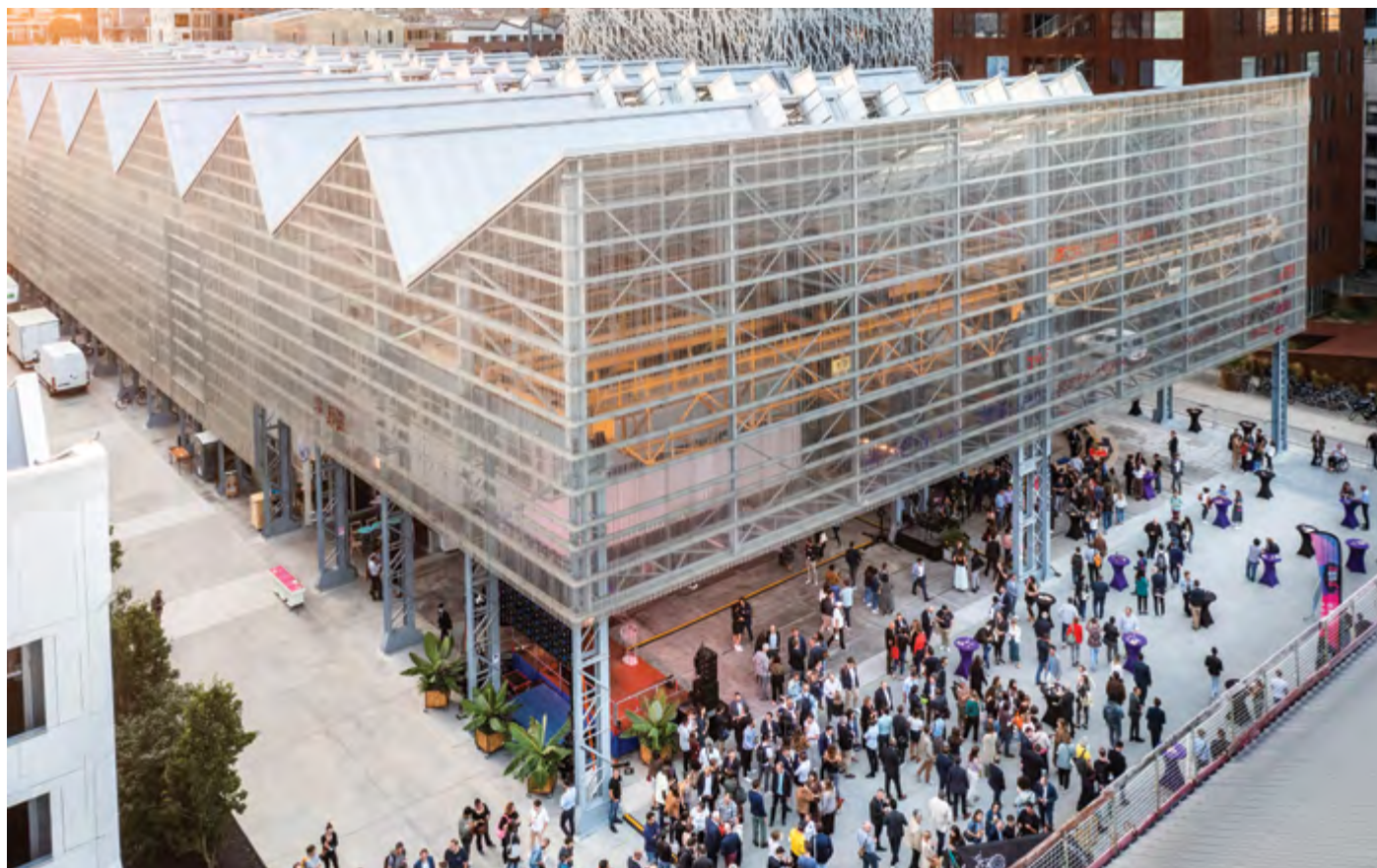
Parvis de l'École des beaux-arts Nantes Saint-Nazaire, site Nantes, 2021. Photo : Valéry Joncheray/Samoa.
