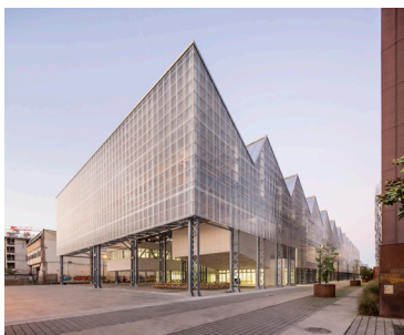
Site de Nantes. Ouvert depuis septembre 2017 Architecture Franklin Azzi, 2017. Photo Luc Boegly
